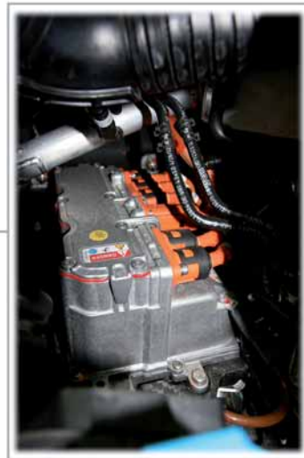
Statt eines Generators, wie bei einem herkömmlichen Verbrennungsantrieb, sorgt im XL1 die Leistungs- und Steuerelektronik für Elektroantrieb JX1 für die Versorgung, Stützung und Ladung des 12-Volt-Bordnetzes.
